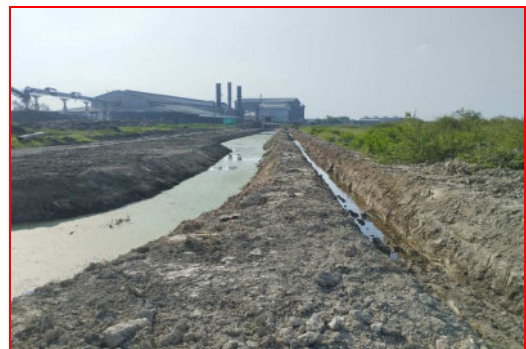
ภาพที่ 2.2-35 การขุดลอกตะกอนและกำจัดวัชพืช บริเวณรางระบายน้ำเสีย
