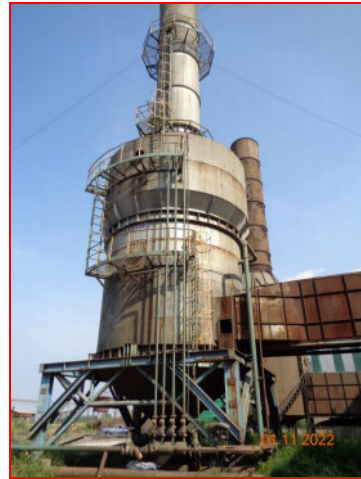
ภาพที่ 2.2-1 ปิ่มสำหรับระบบควบคุมมลพิษอากาศ (Wet Scrubber)
