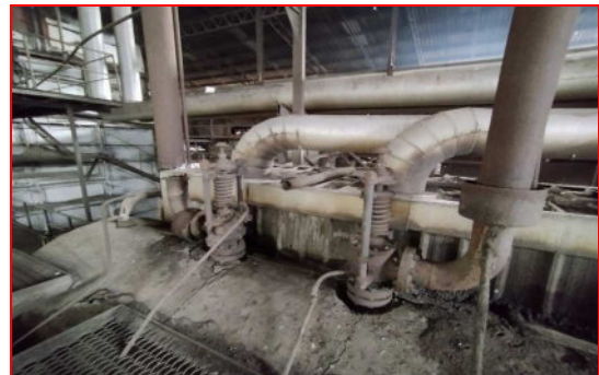
Bypass Valve วาล์วลดความดันของไอน้ำ
