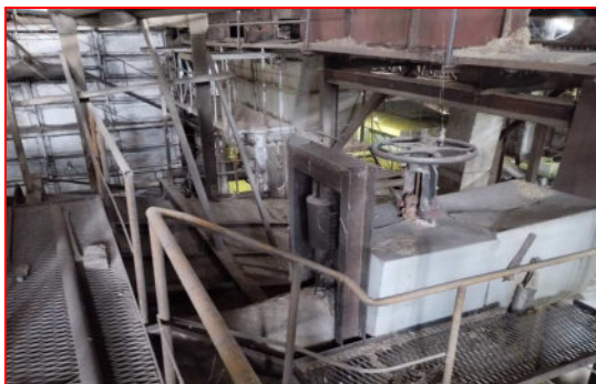
Control Valve วาล์วควบคุมความดันไอน้ำ
