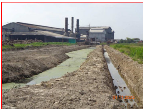
ภาพที่ 2.2-35 การขุดลอกตะกอนและกำจัดวัชพืช บริเวณรางระบายน้ำเสีย
