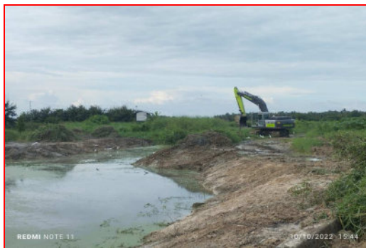
ภาพที่ 2.2-35 การขุดลอกตะกอนและกำจัดวัชพืช บริเวณรางระบายน้ำเสีย
