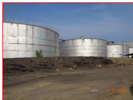
ภาพที่ 2.2-61 การปรับปรุงเชื่อมคันดินรอบถังเก็บโมลาส
